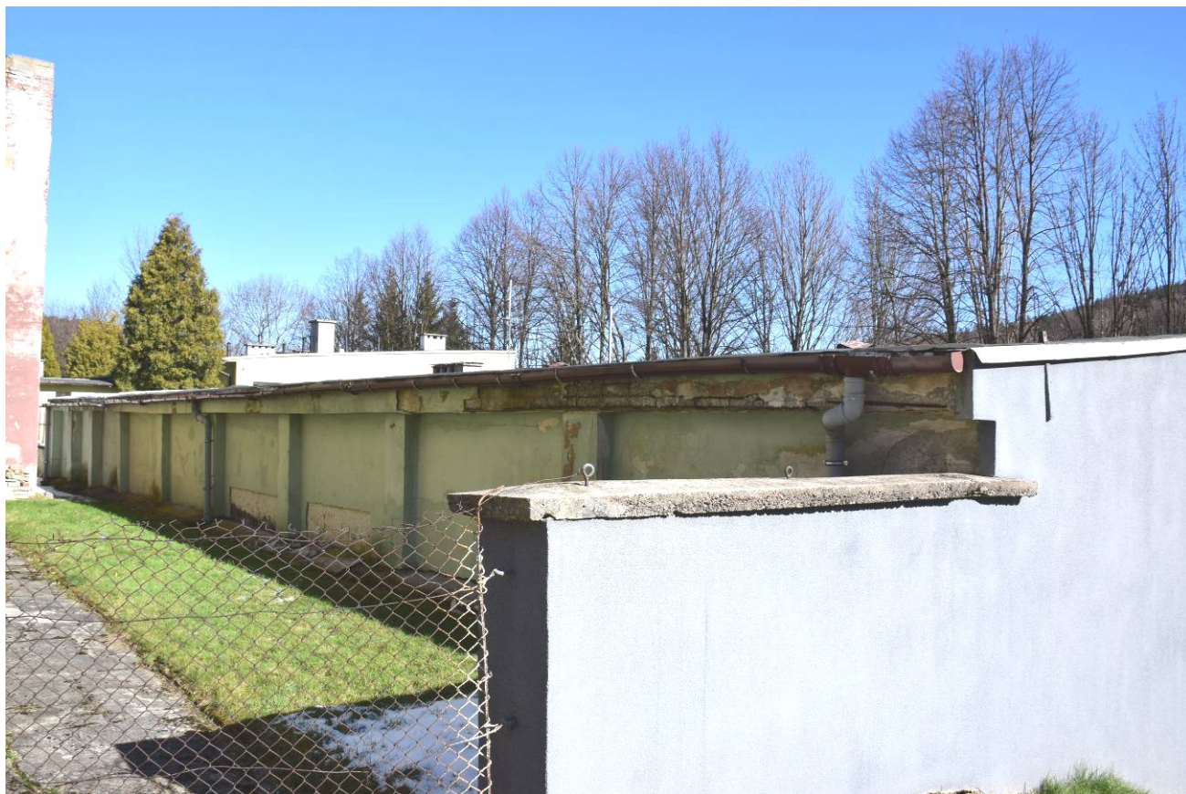
Fot. 2. Elewacja tylna.
