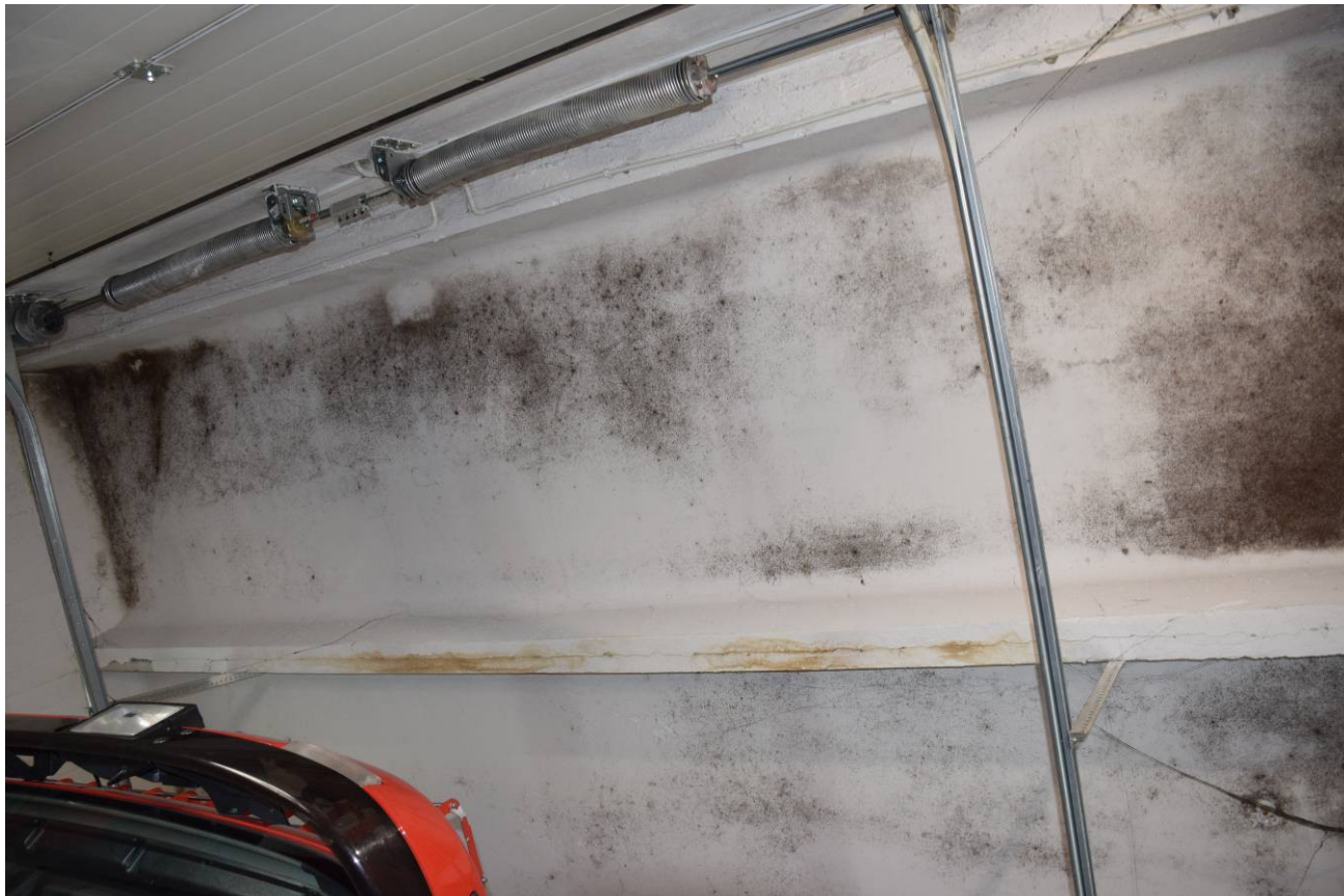
Fot. 6. Sufit (stropodach).
