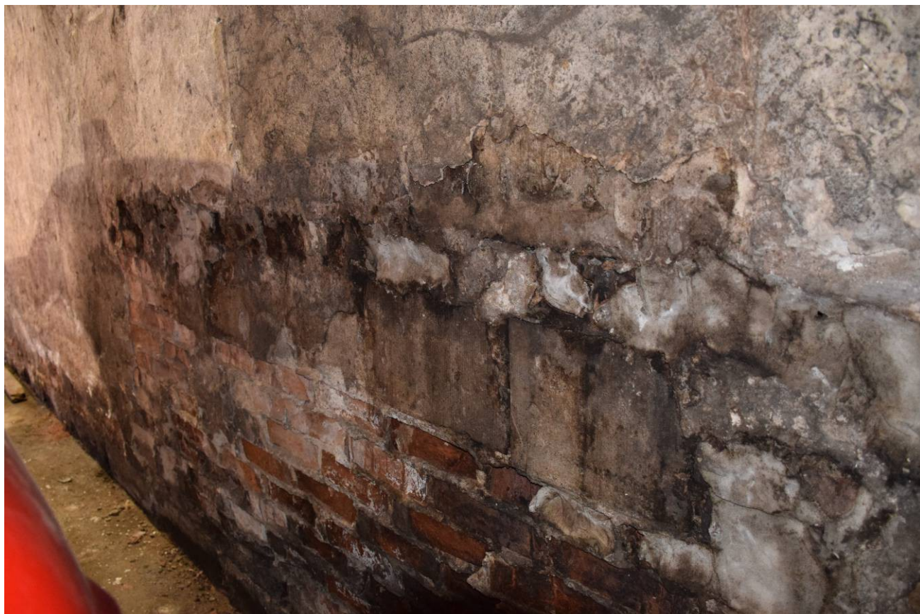
Fot. 5. Ściana południowa od wewnątrz.
