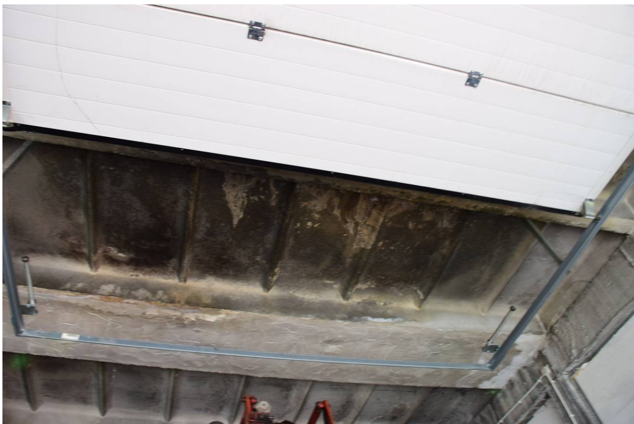
Fot. 7. Sufit (stropodach).
