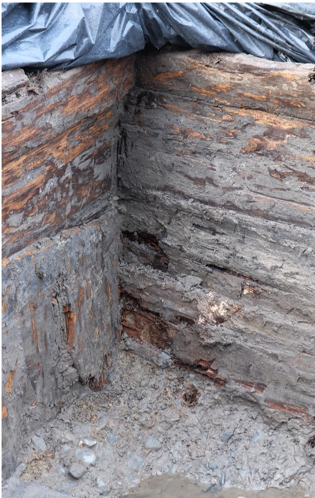
Fot. nr 16. Relikty archeologiczne drewnianej mykwy odkrytej pomiędzy ul. Bulwary a ul. Berka Joselewicza w Oświęcimiu. Narożnik południowo- zachodni. Widoczne zniszczenia struktury drewna belek. Stan przed konserwacją.
