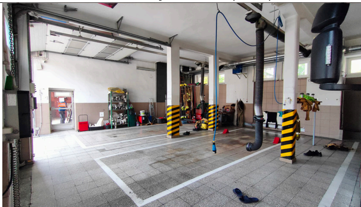
Fot. 4. Pomieszczenie garażu – widok na ścianę południową.
