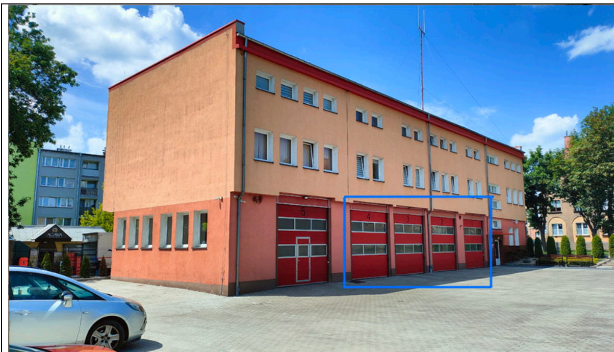
Fot. 1. Budynek JRG w Pyskowicach – widok od strony południowo-wschodniej.
