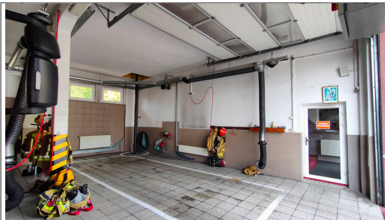
Fot. 5. Pomieszczenie garażu – widok na ścianę północną.
