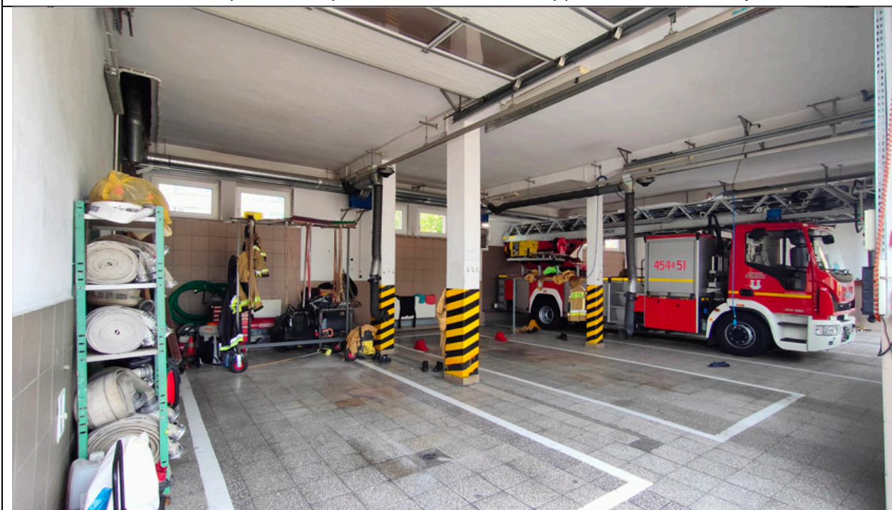
Fot. 2. Pomieszczenie garażu – widok na ścianę zachodnią.
